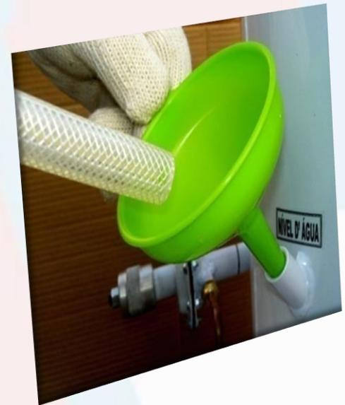
Utilize um funil para encher o cilindro. Não ultrapasse o limite indicado pela etiqueta de Nível d'água.
