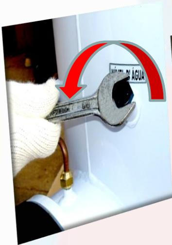
Solte o parafuso de vedação do corpo principal e do tubo de condensação utilizando uma chave fixa girando no sentido anti horário
